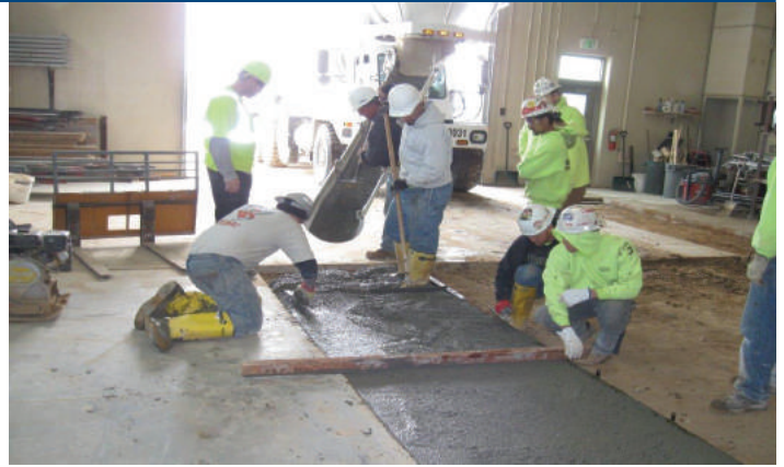
Basic Concrete- Sidewalk Pour
